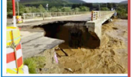
国道38号(南富良野町) 太平橋 橋台洗掘(8/30)
