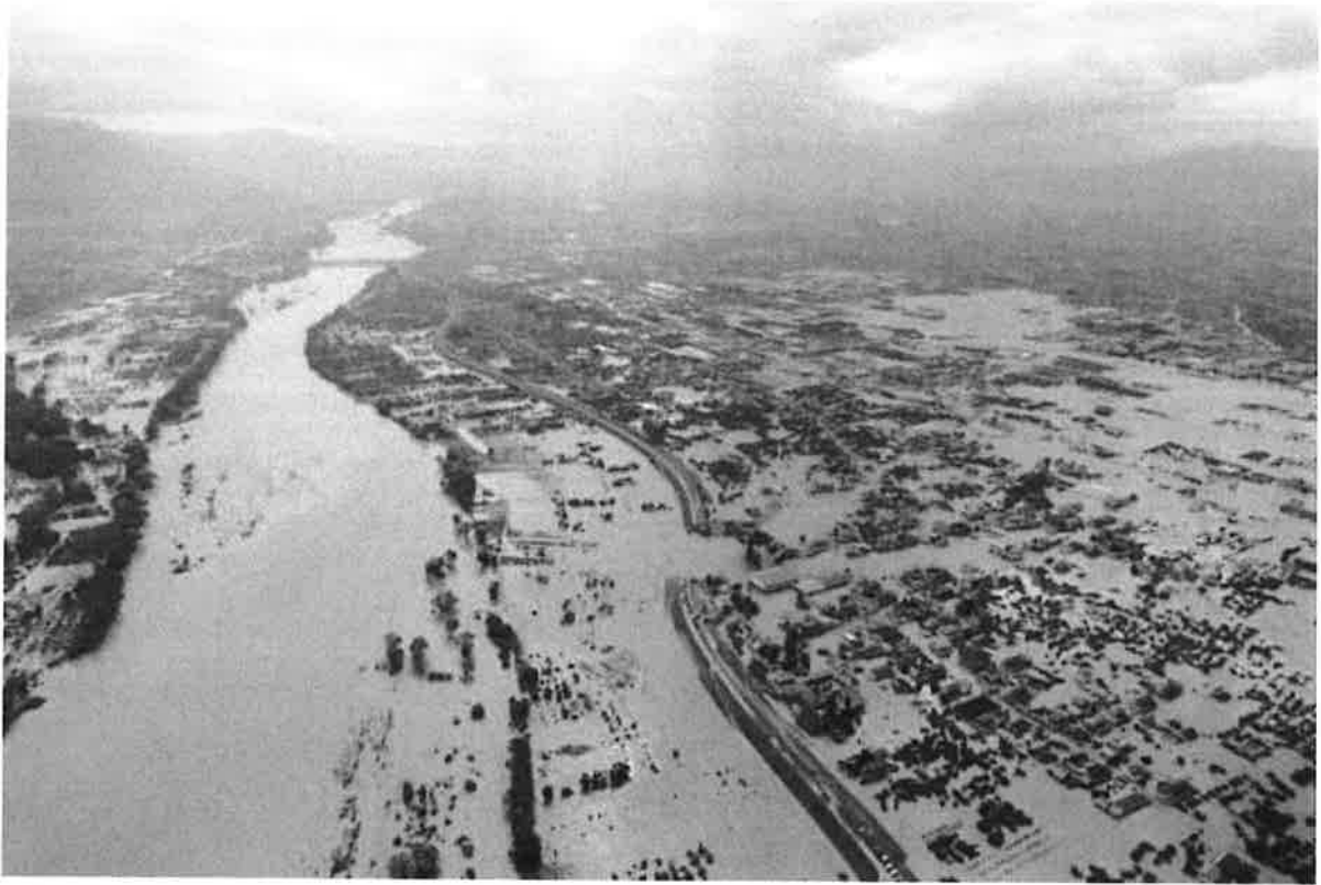
千曲川の堤防が決壊し、大規模浸水した長野市穂保（13日）
