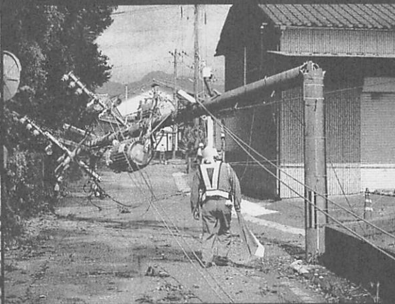
九州の各地で電柱・電線が破損し、停電が発生。宮崎県西都市では、強風によって電柱がへし折られた
