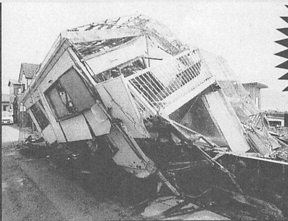
台風10号によって倒壊した鹿児島県枕崎市の海岸沿いに建つ家屋。幸いにも空き家だったため、ケガ人は出なかった
