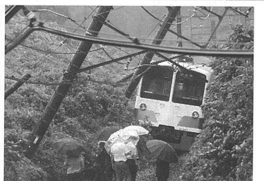
台風9号の豪雨によって線路脇の斜面が崩れた西武多摩湖線
